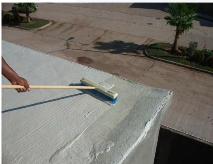
Aplicar una segunda capa de MasaRoca Impermeabilizante en el sentido de la pendiente de la losa, humedeciendo ligeramente la primer capa.
