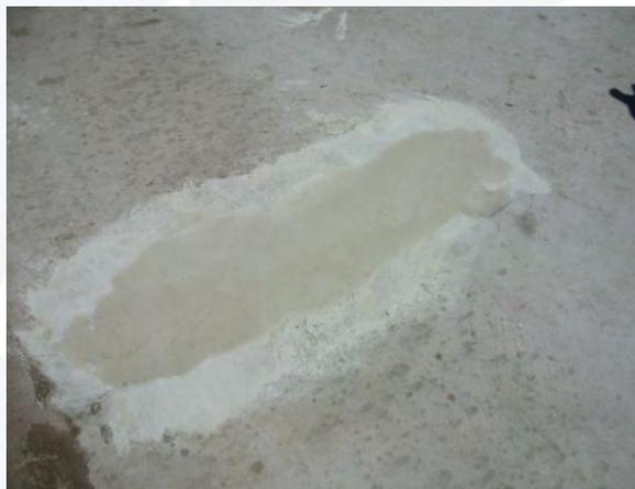
Para varillas o malla electro soldada expuesta debe humedecerse la superficie y aplicar una capa de MasaRoca para cubrir el acero.
