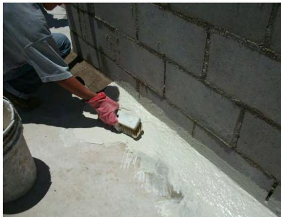
En agrietamientos plásticos de la losa o agrietamientos de los morteros de chaflanes o diamantes, se recomienda resanarlos con MasaRoca a razón de 250 a 275 ml de agua por cada kg de MasaRoca, dejar secar un par de horas.
