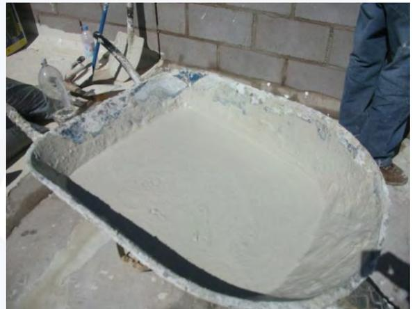
Preparar una Mezcla con 13.5 a 14 lts de agua por cada saco de MasaRoca Impermeabilizante, la mezcla debe ser homogénea teniendo la precaución de no dejar grumos, deje reposar por 3 minutos la mezcla y vuelva a batir antes de aplicar.
