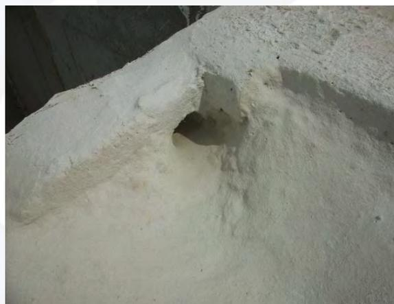
Detalle en domos y bajantes de agua (recubrir perfectamente el perímetro del tubo incluso por dentro)
